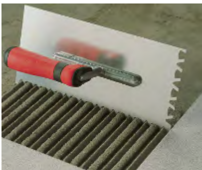
Spezial-Fliesenlegerkelle in Aktion. Special smoothing trowel in action.
