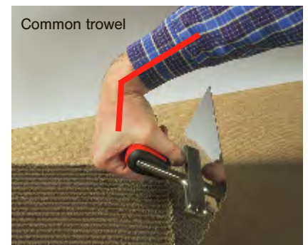
Arbeiten mit der herkömmlichen Glättkelle, verkrampftes Überdehnen des Handgelenks Working with a normal smoothing trowel
